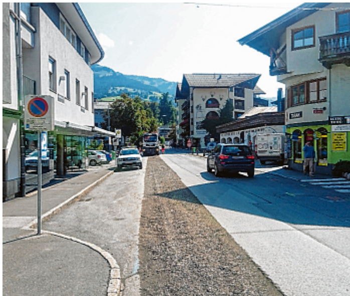
Die ersten Arbeiten an der Jochberger Straße laufen bereits. Bis zur Wintersaison sollen diese abgeschlossen sein. Im Frühling folgt dann Teil zwei der Straßen-Sanierung.
